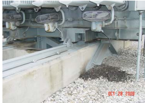
Longitudinal Seismic Restraint
